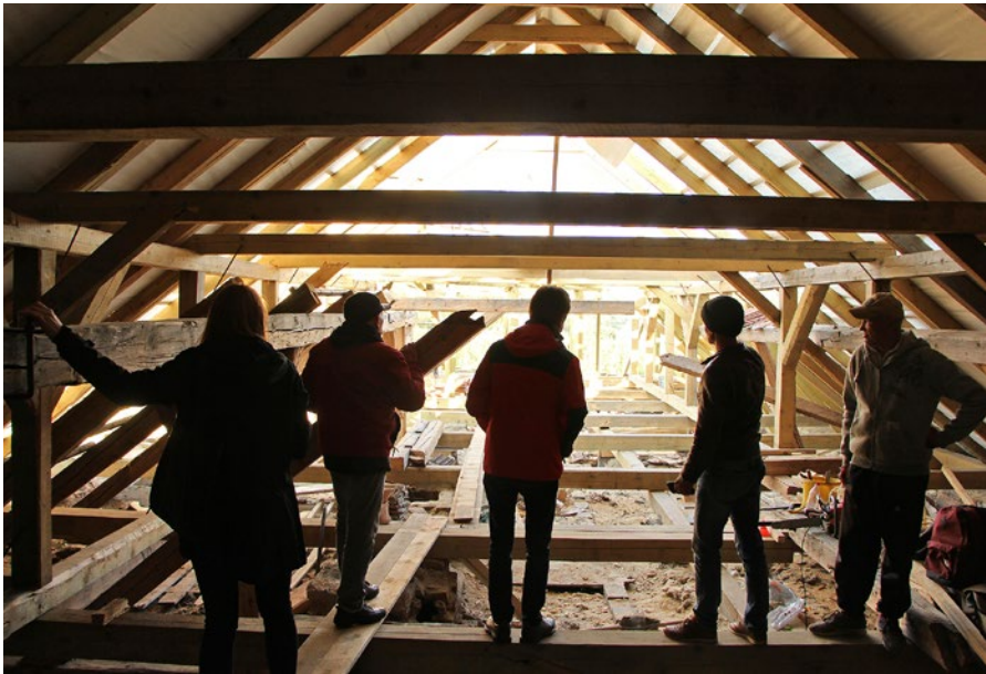
Remont więźby dachowej zabytkowego zespołu klasztornego w Horodence
