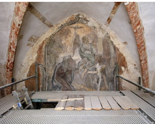
Ściana kaplicy północnej podczas prac konserwatorskich
