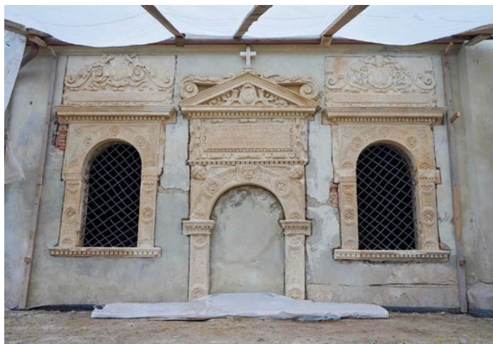
Prace konserwatorskie przy portalu w kościele pw. Najświętszej Maryi Panny w Stryju
