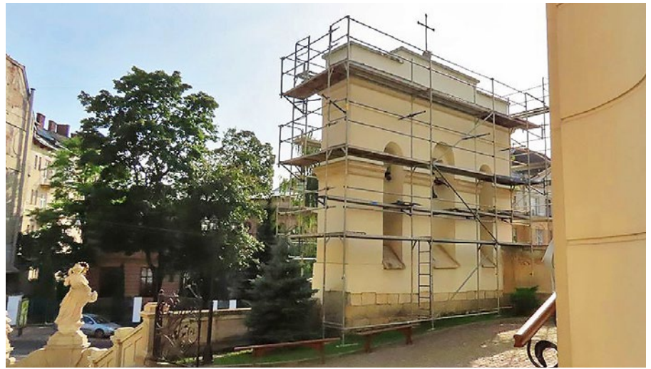
Kościół św. Antoniego, dzwonnica i mur podczas prac budowlano-konserwatorskich
