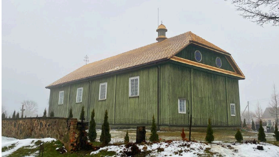
Kościół pw. św. Kazimierza w Powiewiórce po wymianie połaci dachowej
